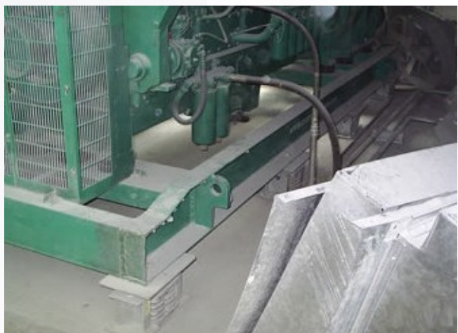
柴油发电机组弹簧减震器安装实例图
