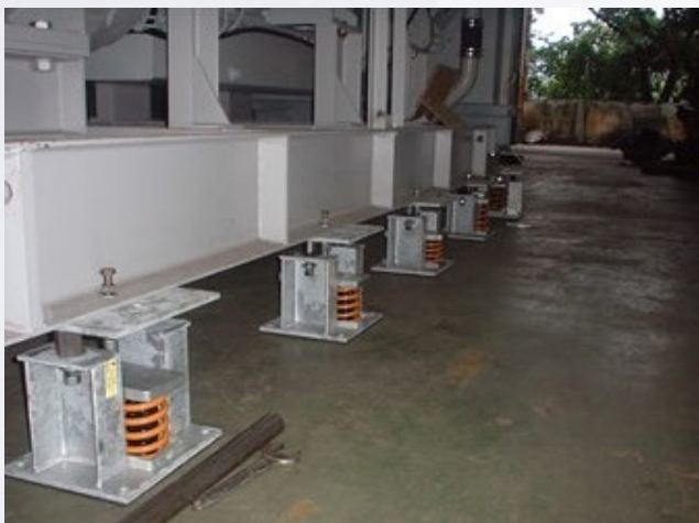
柴油发电机组弹簧减震器安装实例图
