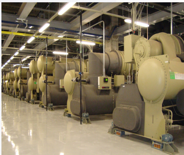
冰水主机（空调主机）减震器安装实例图
