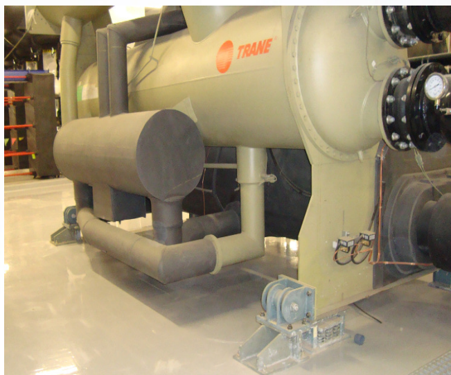
冰水主机（空调主机）减震器安装实例图
