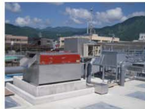
◆河道疏浚污泥处理
