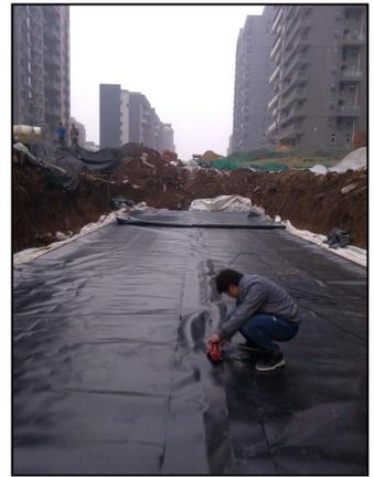
(3) 底板清理完毕，确保无垃圾等之后，铺好土工布、防水膜，把模块进行堆放。
