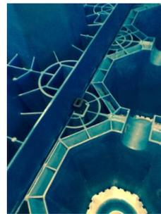
(4) 在模块的顶部一般铺设两层土工布，在顶部回填 10cm 以上细沙，然后开始回填土，防水膜包裹好后顶部先回填部分土壤，以保证水池不会移动。
