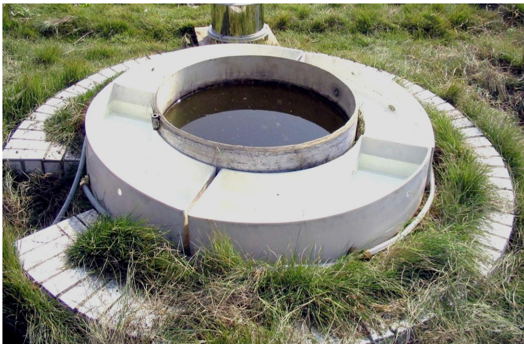
照片 1 蒸发桶在观测场安装后照片
