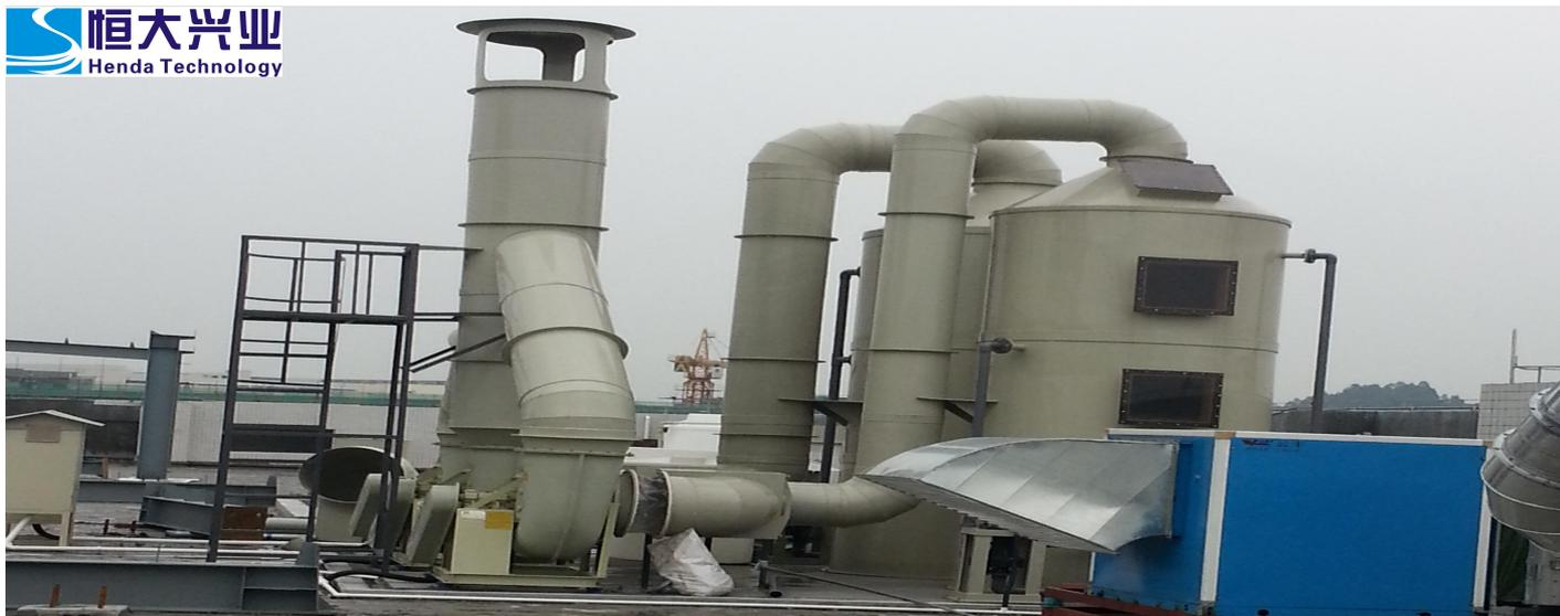
立式洗涤塔最大的特点是通过组合可回收处理废气中可综合利用的原材料，其单机处理风量从每分钟**20**立方米到**1500**立方米，其核心部分洗涤吸收区高度可根据处理气体的不同而调整，填料采用**PP**材质，形状为多齿**TELLERTTE**形，空隙率达到**95%**，比表面积达**90**平方米每立方；除水层的填料采用**PP**材质，形状为圆弧**TELLERTTE**形，空隙率达到**95%**，比表面积达**180**平方米每立方。洒水头采用**PP120**度旋转无堵塞喷头。系统里无金属组件。为此，全系统具有极高的耐强酸性；全系统的阻力小于**50mmAq**，大大节约了能源的消耗量。
