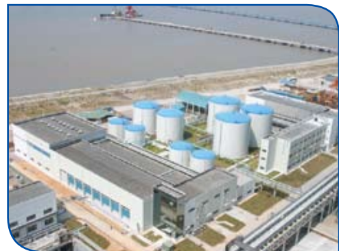
中国 浙江玉环华能电厂海水淡化 77,000 m 3 /d (2006)
