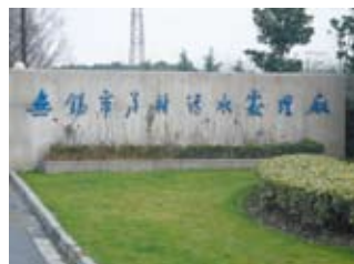
无锡 芦村污水处理厂 244 m 3 /h
