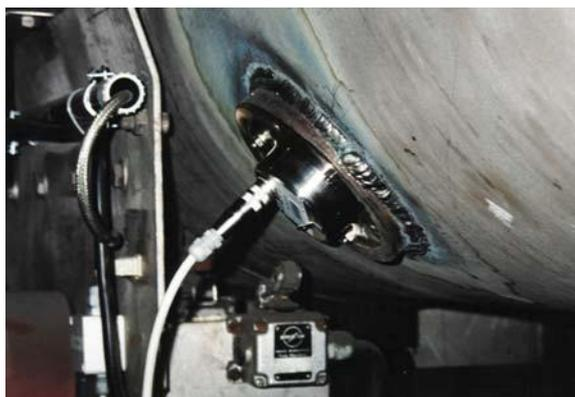
鼓式干燥机后面螺旋输送机上的检测点
