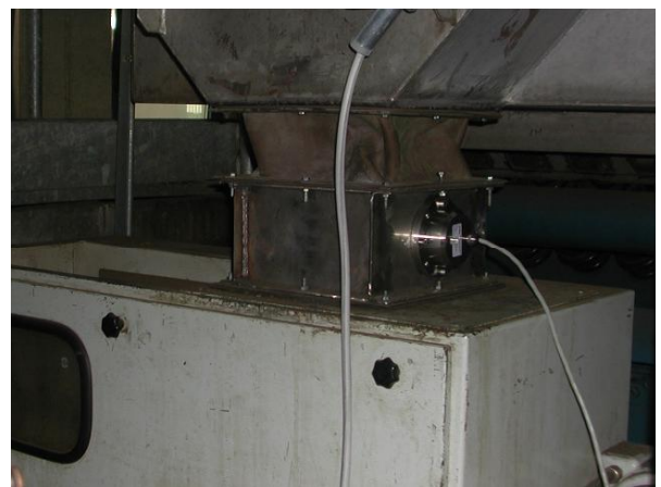
传感器HUMY3000用于物料流的连续性检测
